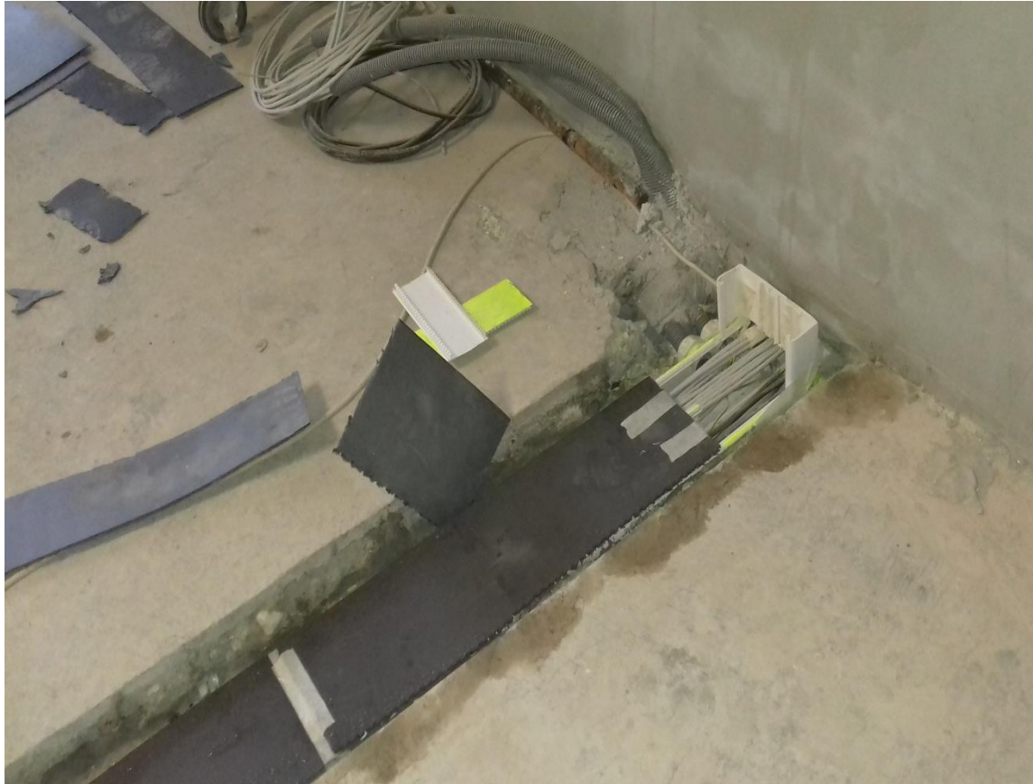
Pokládka rozvodov 230V a IT infraštruktúry do podlahy
